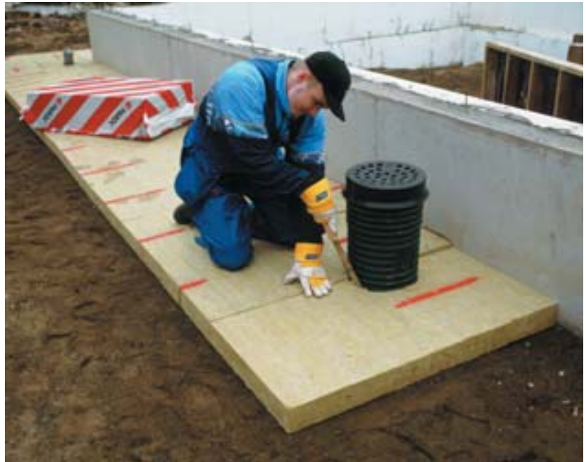
PAROC GRS toimii sekä maanvaraisen lattian eristeenä että routaeristeenä. Eli Vuorivilla ei ime vettä ja toimii kapillaarikatkona.
