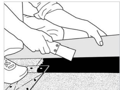
Viimeksi levitetään katon harjalle puolen rullan levyinen PintaUltra siten, että se ulottuu noin 170 mm kummallekin lappeelle. Harjakaista kiinnitetään Icopal Saumaliimalla.
