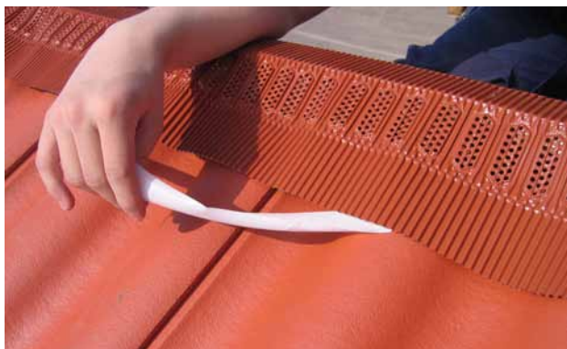
Montering steg 2. Tag bort skyddsteipen parallellt med läggningsriktningen.
