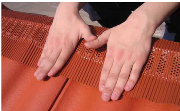
Montering steg 3. Vik ner kanten, forma rullen mot takpannornas toppar. Var noga med att luftningsdelen på rullen ej hamnar direkt mot nockplankan. Luften skall gå fritt från underkant av takpanna tills den går ut under nockpannan.
