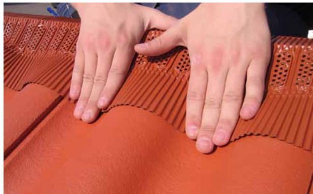
Montering steg 4. Pressa från toppen på takpannan ner mot vågdalen. Var noga med att kanten sluter till ordentligt, för en optimal tätning mot takpannorna.
