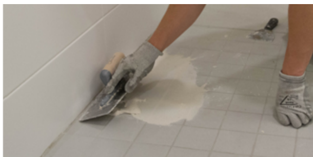
Pohjalaastin levitys tapahtuu Dekofloor pohjalaastilastalla
