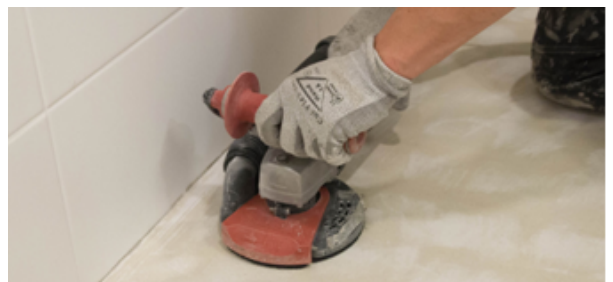
Pohjalaastin pinta hiotaan jatkuvakehäisellä timanttikuppilaikalla
