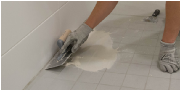
Pohjalaastin levitys tapahtuu Dekofloor pohjalaastilastalla
