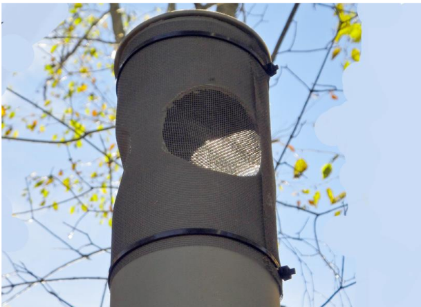
Kuva 8. Tuuletusputken yläpää
