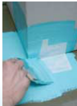
Hierrä ulkonurkkavahvike märkään Kerafiberiin ja sivele yli.
