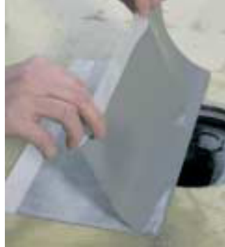
Kiinnitä laippa primeroituun pintaan ja tee sama laipan toiselle puolelle.
