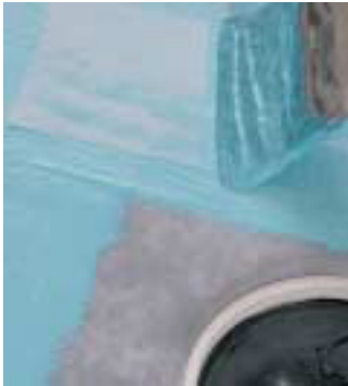
Asenna laipan kahdelle sivulle vahvikekangas vähintään 30 mm laipan päälle.
