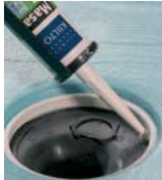
Täytä kiristysrenkaan ja kaivon välinen rako Masa Liimamassalla.
