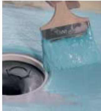
Sivele laippa Kerafiberillä kiristysrenkaaseen asti.
