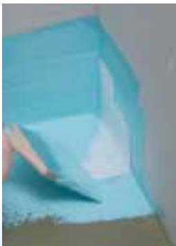
Hierrä sisänurkkavahvike märkään Kerafiberiin ja sivele yli.
