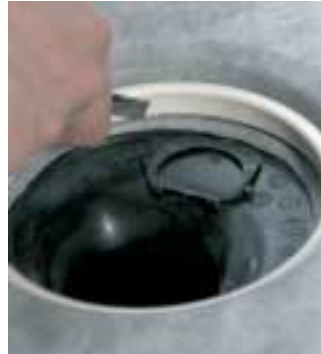
Poista ylimääräinen laipan reuna mattopuukolla.
