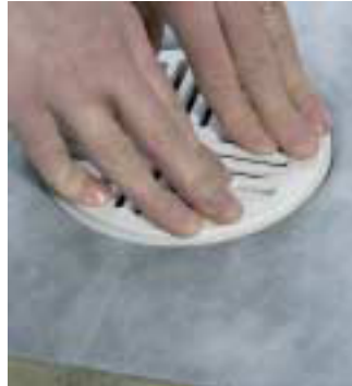
Paina kiristysrenkas varovasti paikoilleen.
