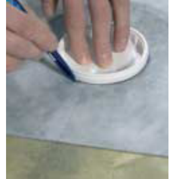
Merkkaa leikattava alue. Huomioi kaivonvalmistajan ohjeet.
