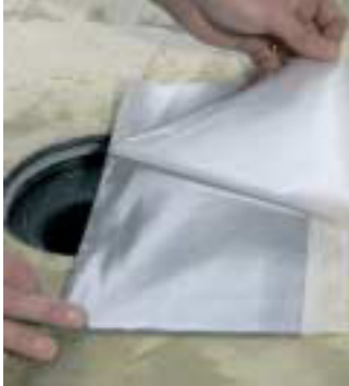
Taivuta laippa ja keskitä se kaivon päälle. Poista suojapaperi.
