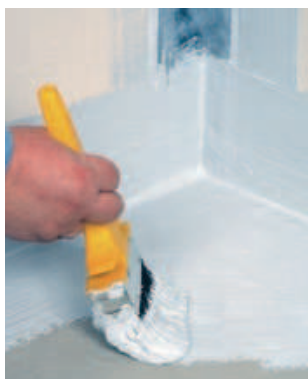
Levitä Mapegum WPS -vedeneristysmassaa vähintään kahteen kertaan. Seuraava kerros voidaan levittää edellisen kuivuttua.
