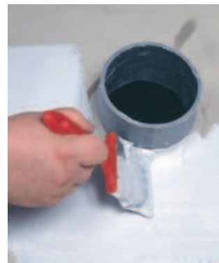
Mapegum WPS -vedeneristysmassaa levitetään runsaasti tiivistysmassauksen yli.
