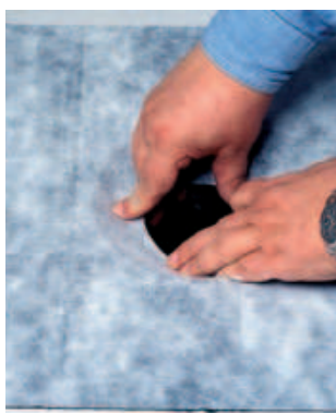
Paina MapeArk tiiviisti alustaan. Leikkaa keskelle n. 65 mm reikä. Paina MapeArk tiiviisti kaivon pintaan.
