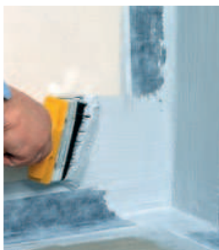
Levitä Mapegum WPS -vedeneristysmassaa nauhojen päälle ja reunojen yli.
