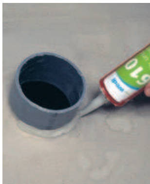
Tiivistä lattian läpiviennit vastavalla tavalla wedi 610 -tiivistysmassalla.
