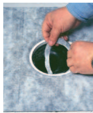
Asenna kiilarengas ja leikkaa pois kiilarenkaan alapuolelle jäävä osa MapeArk:sta.
