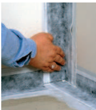
Asenna MapeTape- tai WPS-vedeneristysnauha vastaavalla tavalla pystynurkkiin. Limitä nauhat vähintään 3 cm.
