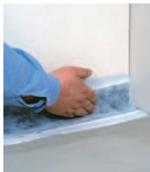
Asenna MapeTape- tai WPS-vedeneristysnauha tiiviisti märkään massaan.
