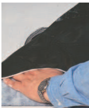
MapeArk-kaivokappale suositellaan asennettavaksi kuivuneeseen Mapegum WPS -vedeneristysmassaan.
