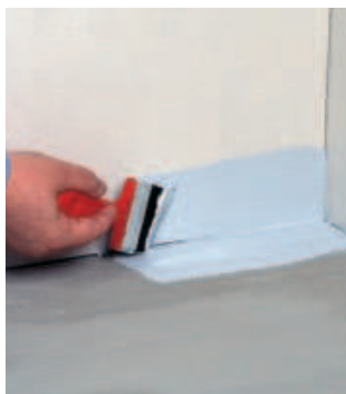
Levitä Mapegum WPS -vedeneristysmassaa lattian- ja seinän liitoskohtiin.
