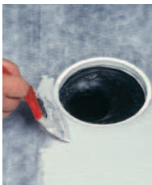
Levitä Mapegum WPS -vedeneristysmassaa lattiapinnalle, MapeArk:n päälle ja koko kiilarenkaan yli.
