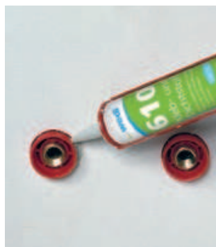
Tiivistä läpiviennit wedi 610 -tiivistysmassalla tai MapeTape -vedeneristysnauhalla.
