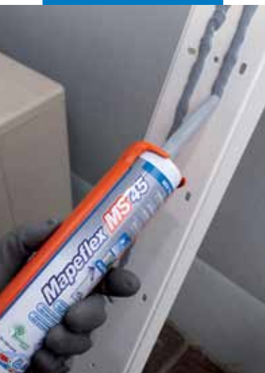
Muoviprofiilien liimaus ulkotiloissa
