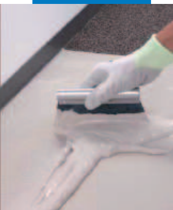
Alustan ollessa päällystyskelpoisen levitä liima.
