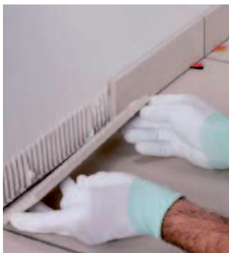
Asenna jalkalista siten, ettei se kosketa lattiapäällystettä.
