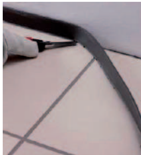
Saumauksen valmistuttua leikkaa pois ylimääräinen Mapesonic Strip-irrotuskaista.
