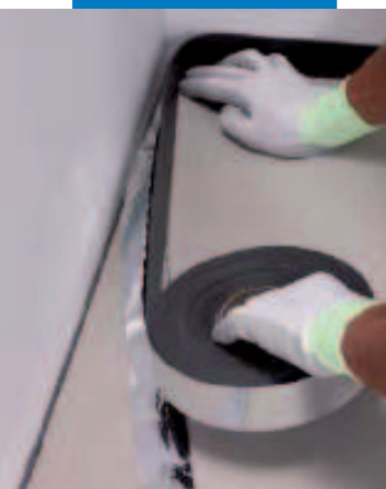
Asenna Mapesonic Strip ympäröivän tilan pystypinnoille.
