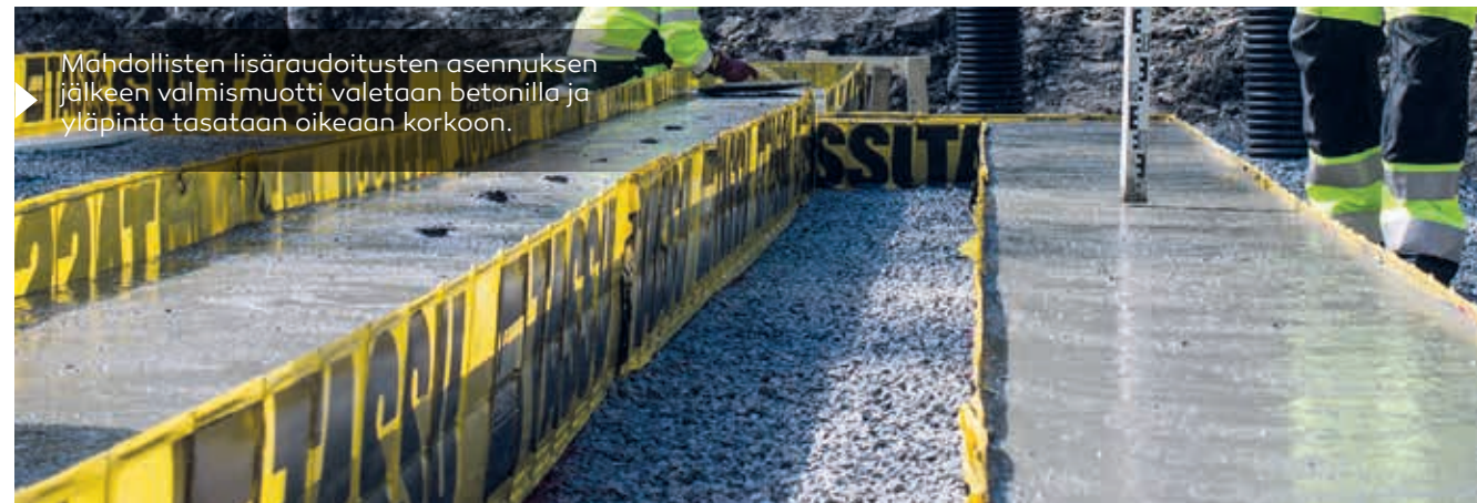
Kun betoni on kovettunut, muottia ei tarvitse purkaa. Näin tontille ei kerääny rakennusjätettä.
