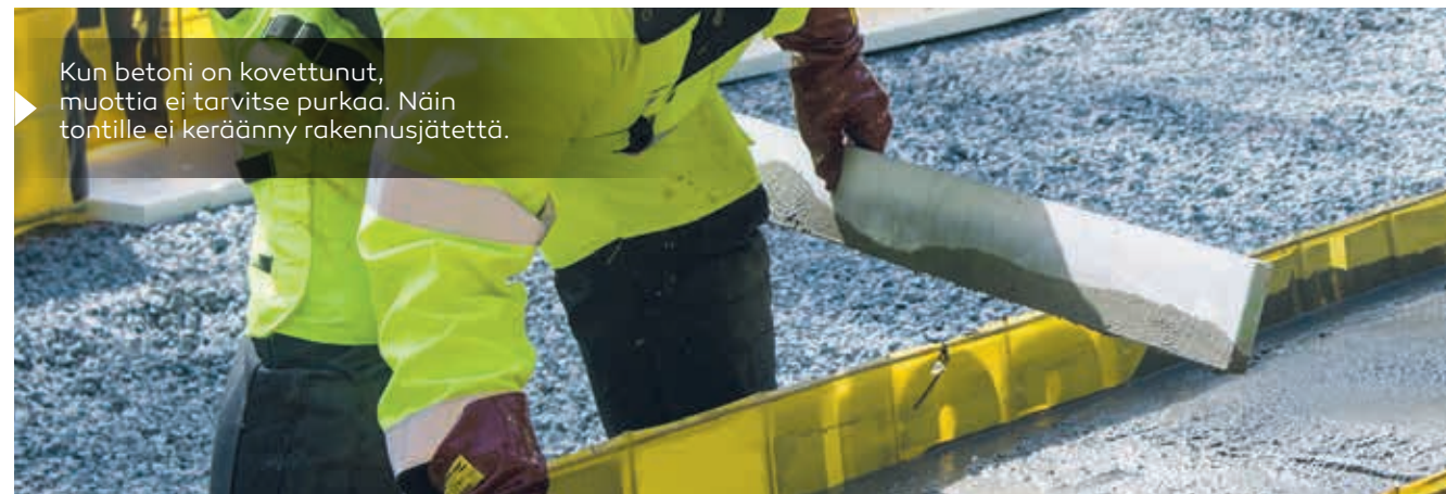
Valmismuotin avulla myös monimuotoisen rakennuksen antura on mahdollista tehdä ja valaa valmiiksi päivässä.
