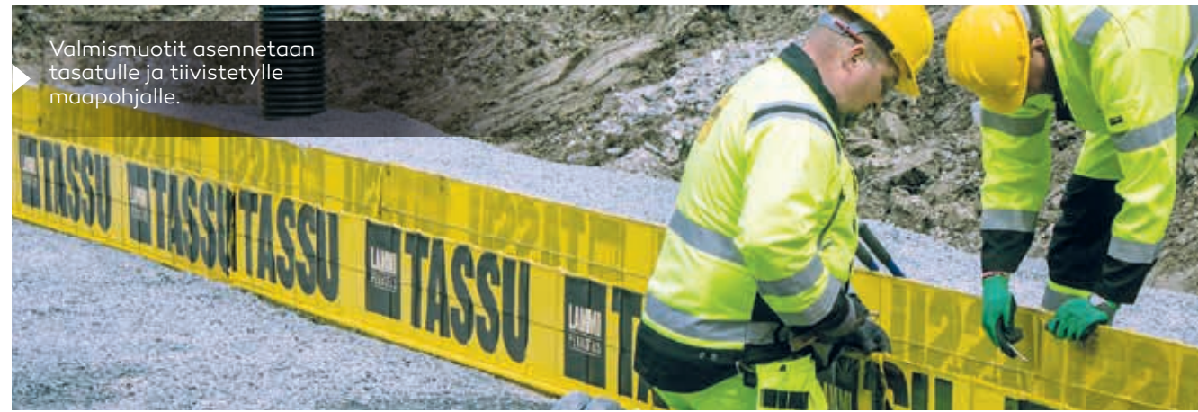
Mahdollisten lisäraudoitusten asennuksen jälkeen valmismuotti valetaan betonilla ja yläpinta tasataan oikeaan korkeuteen.
