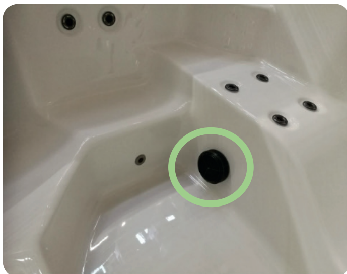
Imusuutin: TÄTÄ SUUTINTA EI SAA TUKKIA, eikä sen päälle saa astua.
