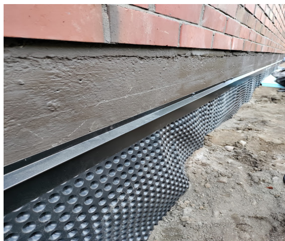
Kuva 2. Kivijalka, patolevy ja KUIVAKS- reunalista
