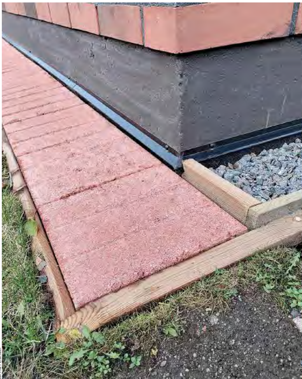
Työmaan ollessa valmis, patolevyn reunalista jää näkyviin maanpinnan yläpuolelle.
