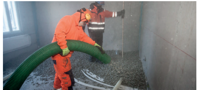
Väestönsuojan päällisen täyttö
