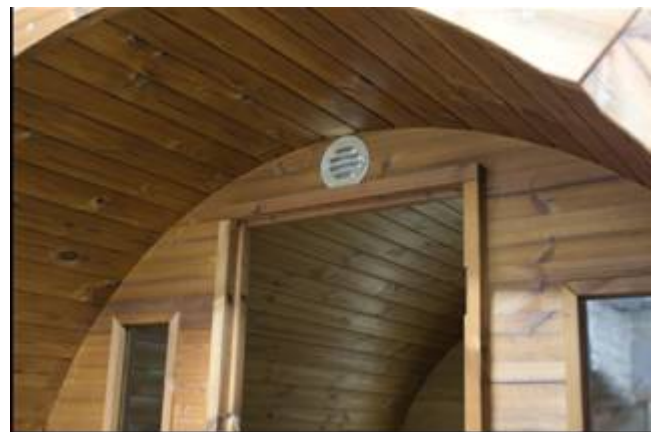
Ruuvaa kiinni tuuletusventtiili.
