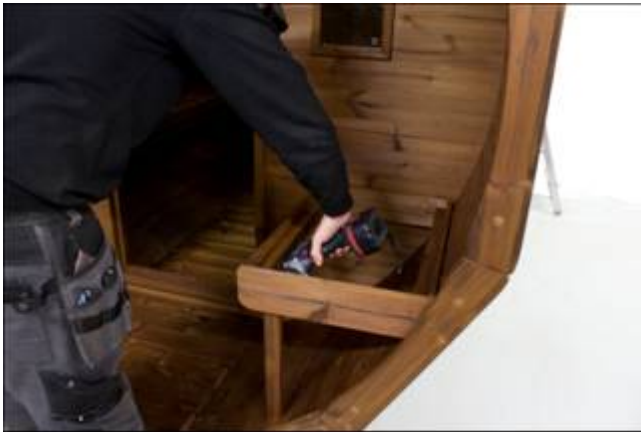
Asenna tukijalka. Tukijalat ruuvataan kiinni seinään ja istuimeen (45mm, puutappi 8x35). Alla olevasta kuvasta näkyy istuimet asennettuina.
