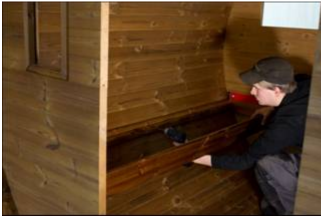
Ruuvaa kiinni istuinkehikko (ruuvireijät mekattuina)
