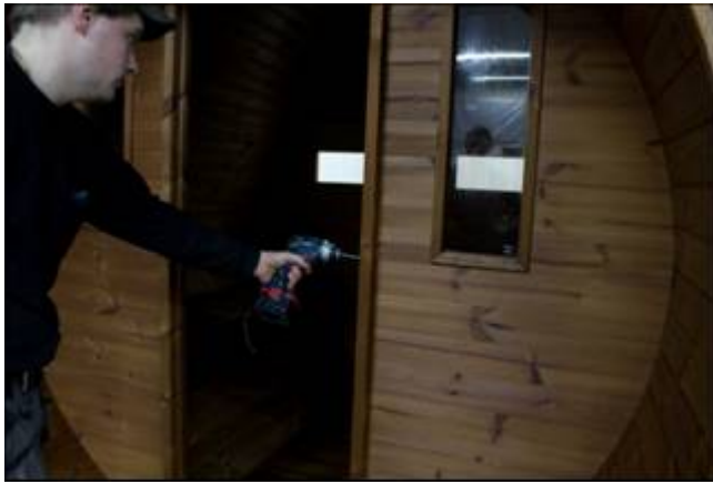
Aseta karmi oviaukkoon ja ruvaa se kiinni (ruuvireijät merkattuina, 55mm).
