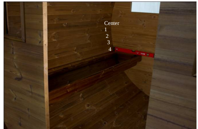
Irroita istuinosa kehikosta ja sijoita kehikko saunaan, käytä vesivaakaa että saat sen suoraksi. Istuin sijoitetaan neljä sivulautaa alle keskilaudan.
