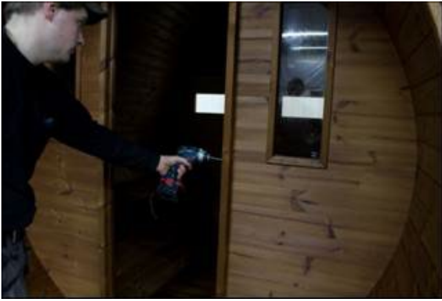
Aseta karni oviaukkoon ja ruuvaa se kiinni (ruuvireiät merkattuina, 55 mm).
