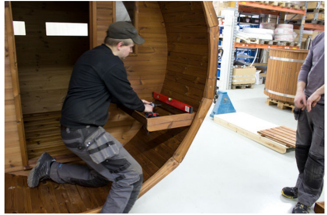
Asenna ulkoistuimet samalla tavalla kuin sisäistuimet.
