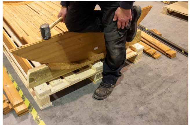
Lyö moduulia varovasti kumivasaralla. Käytä kehon painoasi moduulin painamiseen alaspäin.
