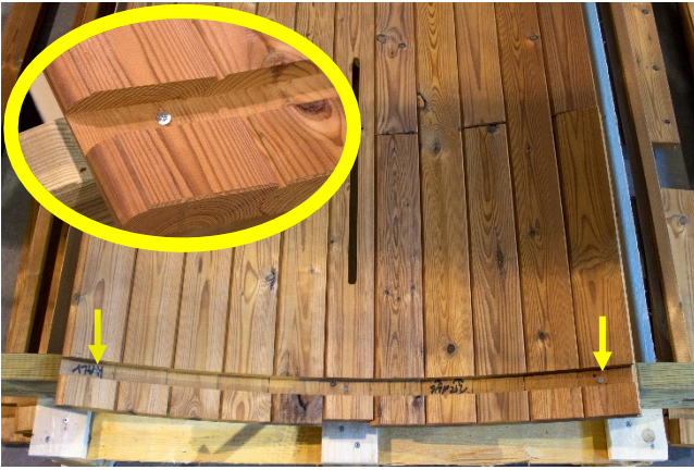
Ruuvaa sitten ulommat laudat edellä ja takana. Ruuva kiinni 5. lauta molemmilta puolilta keskeltä kiinni.
