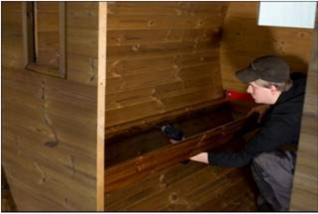
Ruuvaa kiinni istuinkehikko (ruuvireiät merkattuina)
