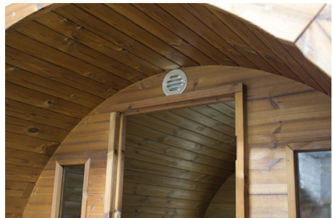
Ruuvaa kiinni tuuletusventtiili.
