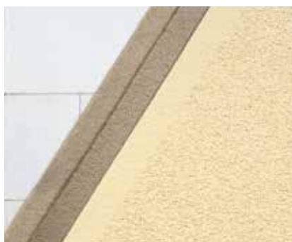
Kuva 11. Kaksikerrosrappaus, rakennekerrokset
