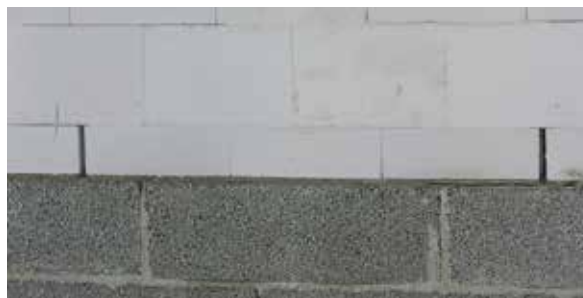
Kuva 10. Kuorimuurin liitos sokkeliin
