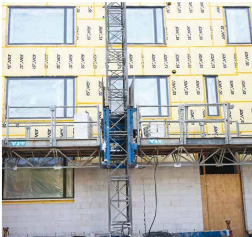
Kuva 12. Kahi Facade -julkisivurakenteen toimivuus on testattu taulukossa 12 mainituilla laasteilla. Rakenne on läpäissyt vaativan 100 kierroksen jäädytysulatus-testin.
