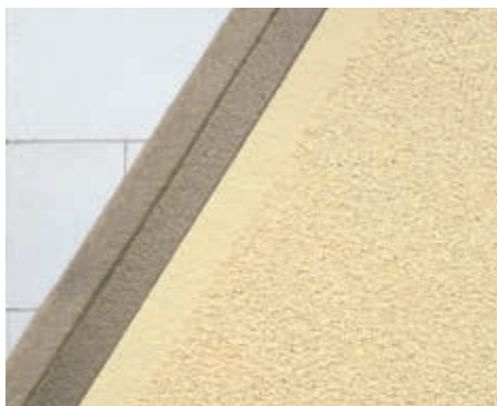
KUVA 25. Kaksikerrosrappaus, rakennekerrokset
