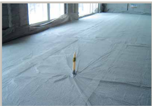
Floor 4940 Erotuskankaan asennus
