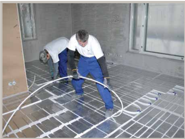
Lämpöputkien asennus
