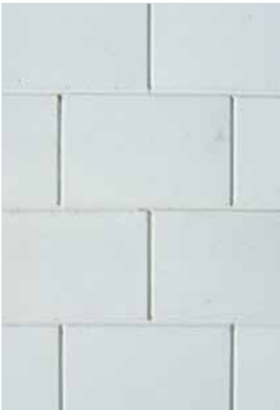
Kahi-viisteharkkoilla ja -viistetiillä toteutettuja limitysmalleja.
