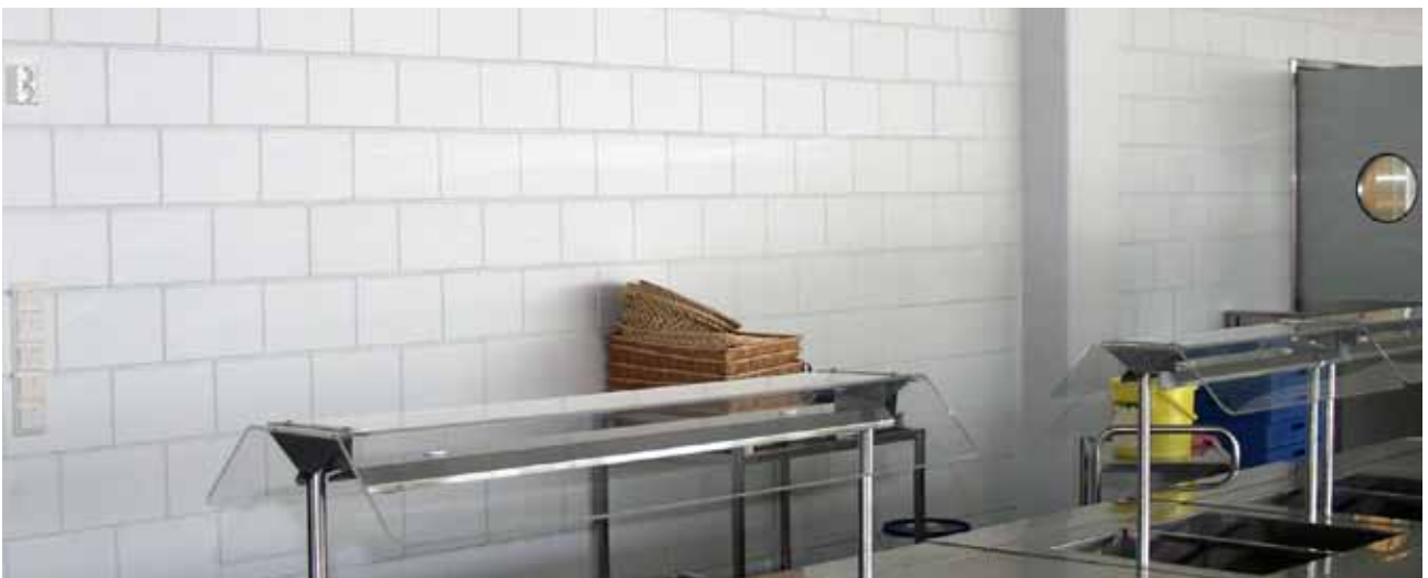
Kahi-viisteharkkoilla ja -viistetiillä toteutettuja limitysmalleja.
