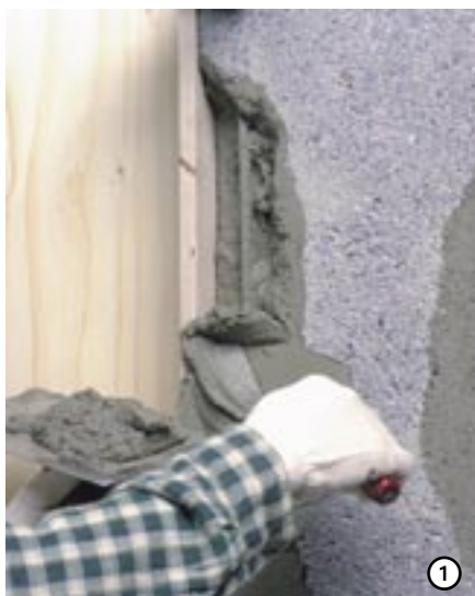
1 Kulman täyttö tehdään ohjurlautaa apuna käyttäen.
