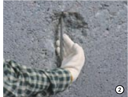
Paikattavan alueen teräkset on puhdistettava kauttaaltaan huolellisesti.
