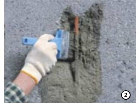
Tartuntakerros harjataan voimakkaasti karkeaksi tartunta-alustaksi.
