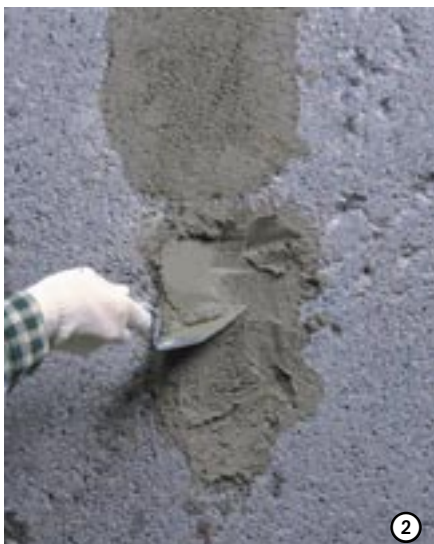
2 Paksut täytöt: alemman kerroksen pinta leikataan, ei hiehtetä.
