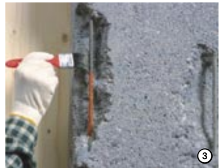
Teräkset suojataan REP 05 -korroosionestolaastilla.
