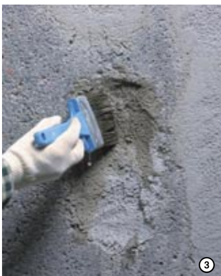
3 Välikerroksen kostutus ennen uutta täyttöä.
