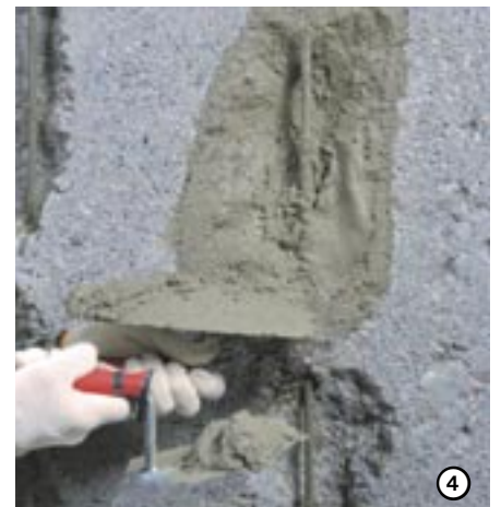
Korjauskohteen täyttö kauhalla.
