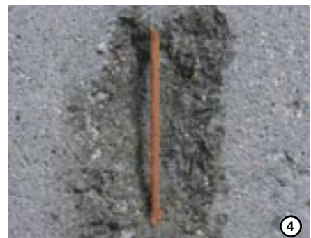
Paikattava alue kostutetaan korjaustyötä edeltävänä päivänä.
