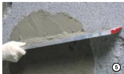
5 Suuremmissa pinnoissa käytetään esim. teräväpäistä alumiinilinjaaria
