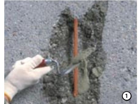
"Mattakosteaan" vauriikohtaan levitetään tartuntakerros.
