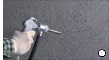
Korjattava alue puhdistetaan esim. hiekkapuhaltamalla.
