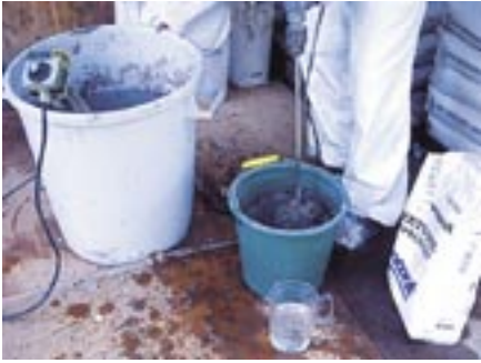
Massa sekoitetaan porakonevispilällä.
